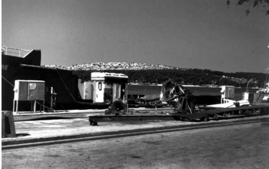
Slika 3. Brod u rekonstrukciji bez staroga nadgrada – Remontno brodogradilište u Šibeniku
